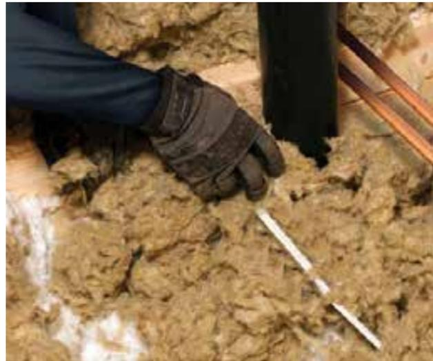
*Les petites ouvertures et les vides dans le grenier autour de la tuyauterie, du câblage et des événements de toit que l'on néglige souvent d'isoler peuvent contribuer jusqu'à 30 % de la perte de chaleur. L'isolant d'appoint en vrac pour grenier ROCKFILL™ de ROXUL vous facilite la tâche; en effet, il n'est pas nécessaire d'utiliser une souffleuse, car la pose se fait à la main, ce qui n'est pas possible avec d'autres types d'isolant de grenier.*
